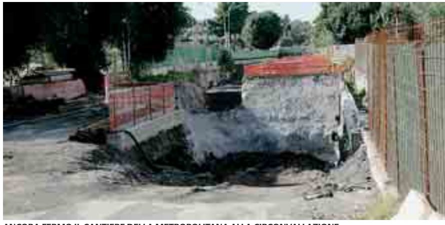
ANCORA FERMO IL CANTIERE DELLA METROPOLITANA ALLA CIRCONVALLAZIONE
