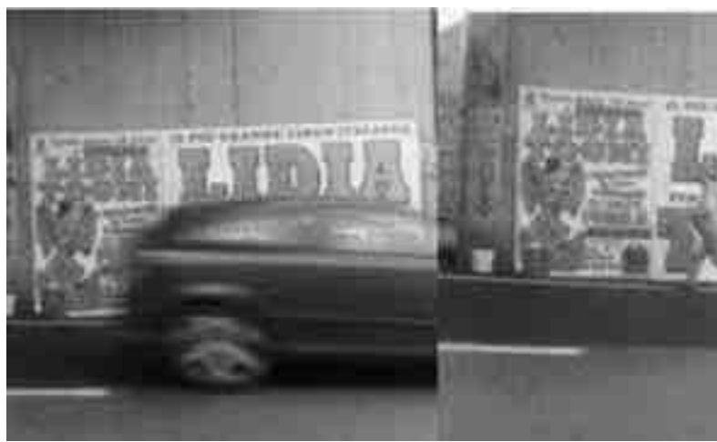
LE ARCADE DEL PONTE DI VIALE ULISSE IMBRATTATE DA CARTELLONI ABUSIVI
